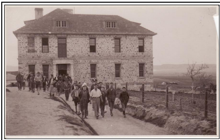
Περίπου 1930 το Princeton Hall τελειωμένο με ελάχιστα δέντρα γύρω. Εδώ οι μαθητές εξέρχονται από το Assembly Hall που είναι στο βόρειο τμήμα του κτιρίου. Επάνω από το Χολ ήταν ο κοιτώνας και στη σοφίτα η ελληνική ορθόδοξη εκκλησία .
